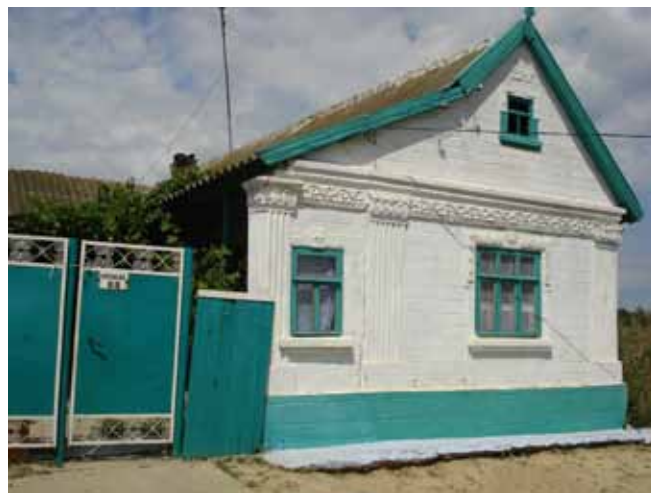
Фото 2. Фасад отремонтированного дома постройки 1-й половины XX-го в.
